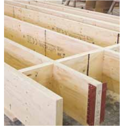
Vorfertigung von Holhkasten-Deckenelementen.
